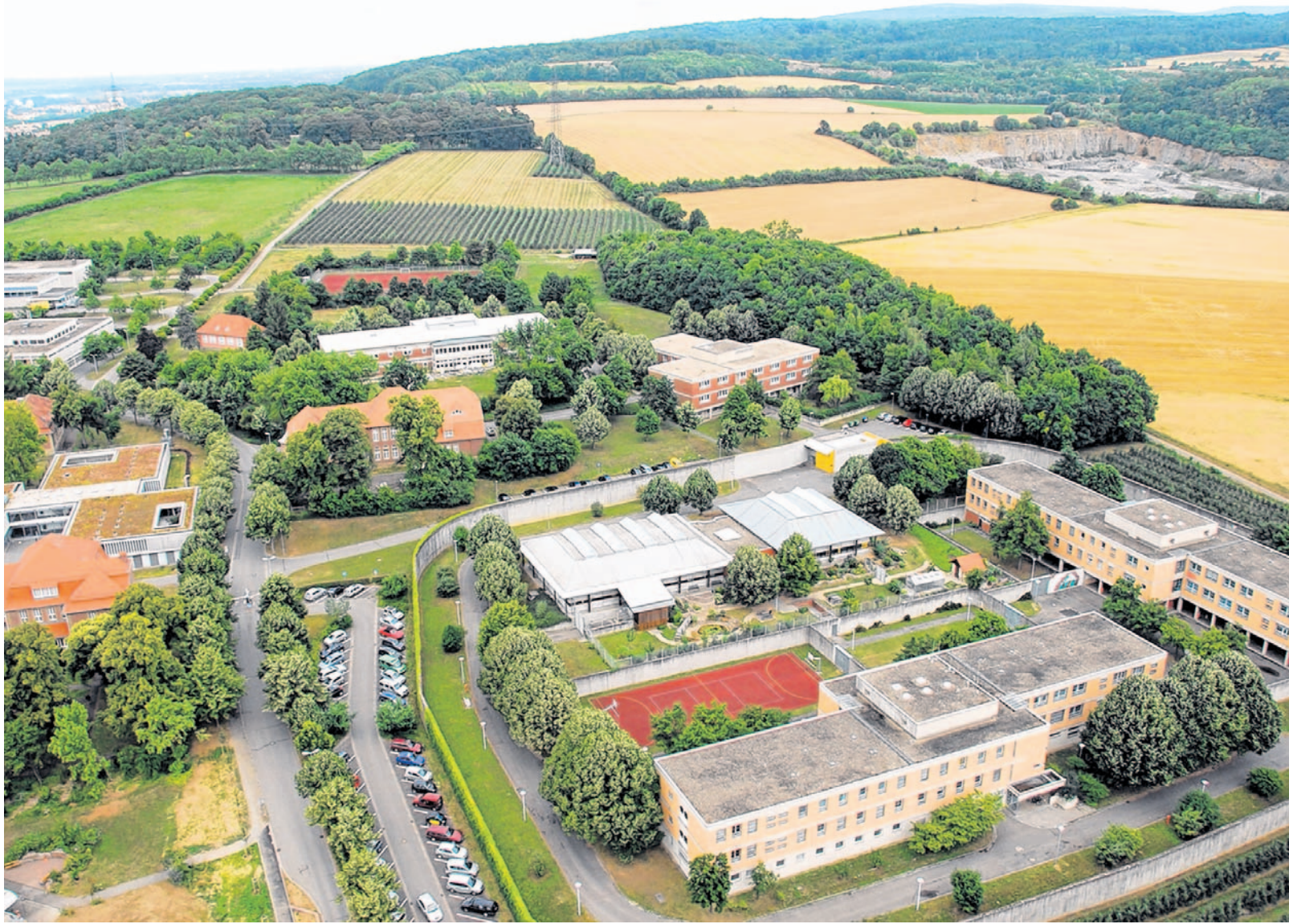
Der Hochsicherheitsbereich der Forensik (rechts unten) ist von einer hohen Mauer umgeben
