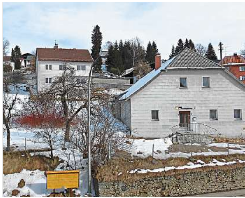
Früher: Bis vor wenigen Jahren standen oberhalb der Grafenauer Straße noch die beiden Unfried-Häuser.
